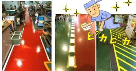
社員の安全意識を高め、職場全体の安全性を底上げするため、赤茶色の安全通路、白線、黄色の危険エリアを整備。従来のテープ貼りによる白線は、耐久性を考慮してスプレー塗装に変更。さらに、劣化していた危険エリアの黄色テープも修繕を施しました。
